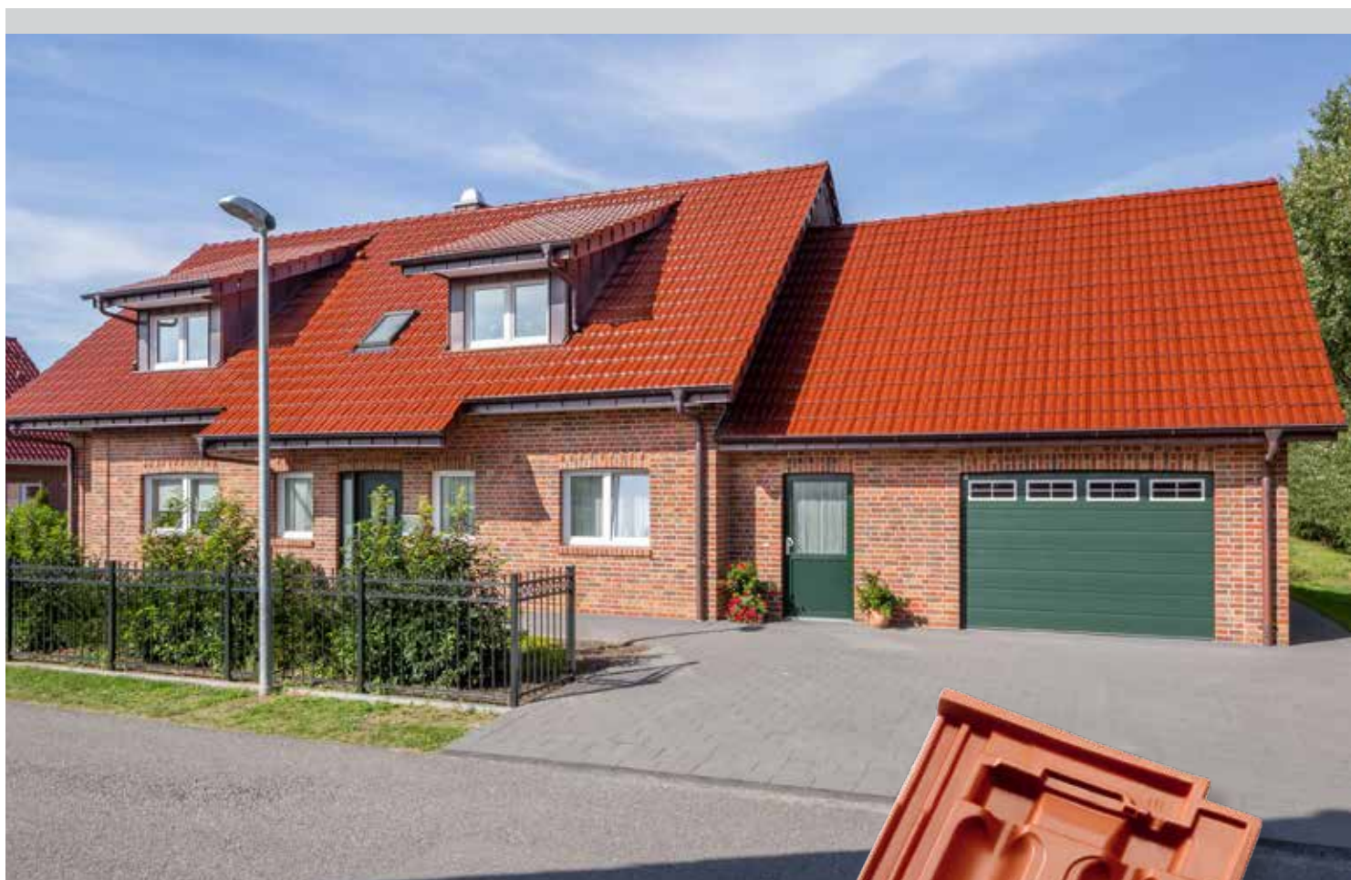
Referenz: Wohnhaus in Bad Lauchstädt, gedeckt mit D10 edelkupfer
