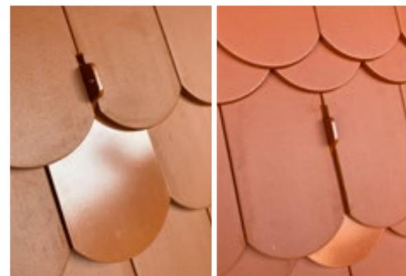
(Bild 2, links Doppeldeckung, rechts Kronendeckung)
