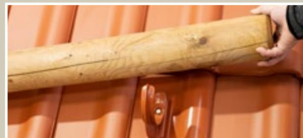
Bevor die Rundholzhalterung auf die Grundpfanne montiert werden kann, muss die aufgeschraubte Mutter mit einem 13-mm-Schraubenschlüssel gelöst werden.
