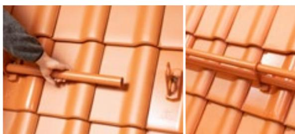
Bevor die Doppelrohrhalterung auf die Grundpfanne montiert werden kann, muss die aufgeschraubte Mutter mit einem 13-mm-Schraubenschlüssel gelöst werden.
