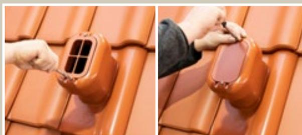
Zur Vorbereitung der Installation bauen Sie bitte den Sanitärlüfter ohne Flexschlauch an die vorgesehene Stelle ein. Danach entfernen Sie den angeschraubten Deckel des Sanitärüfters, um die Position der Abdichtungsmanschette zu bestimmen.
