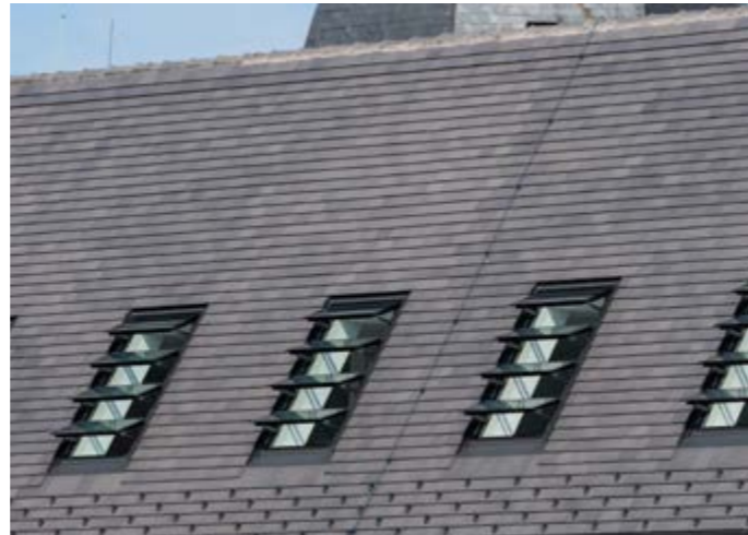
Süddeutscher Biber Geradschnitt, polargrau gedämpft Wiederaufbau der Unteren Mühlen in Bamberg
