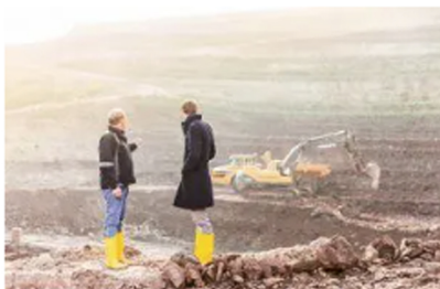
Tonabbau Standort Langenzenn
