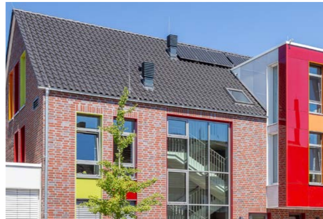
Z5 altschwarz Albrecht-Bedachungen GmbH, Hamm
