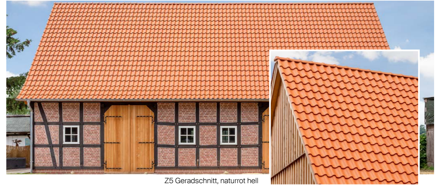
Z5 Geradschnitt, naturrot hell Wiederaufbau einer 200 Jahre alten Scheune an neuem Standort, Jablinski Holzbau, Lilienthal
